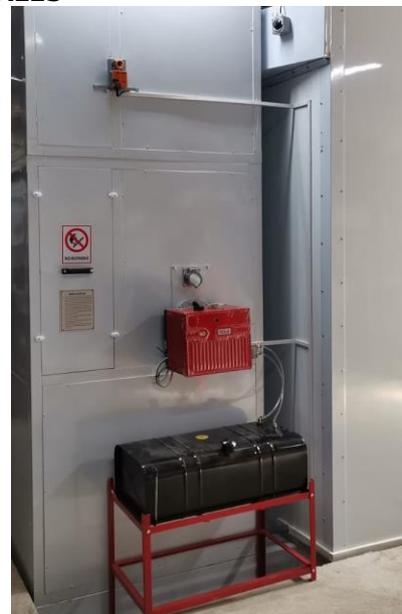
Vista del generador con quemador Riello G20, servomotor BELIMO para el damper y control de temperatura.
